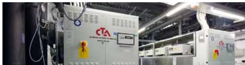
**Deux groupes frigorifiques TECS HF4 fournissent une puissance frigorifique de 1207 kW chacun. Ces modèles sont équipés de compresseurs Turbocor à paliers magnétiques.**
