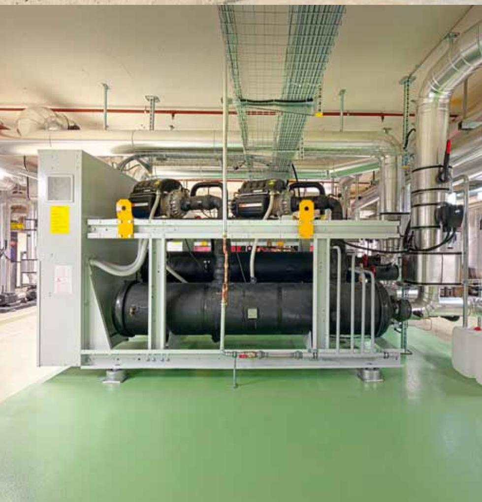
B /// Dans le cadre du programme ECO-21, l'entreprise DuPont de Nemours a décidé de remplacer ses anciens groupes frigorifiques par des installations CTA avec compresseurs Turbocor, permettant ainsi d'économiser quelque 1.5 GWh par an.
