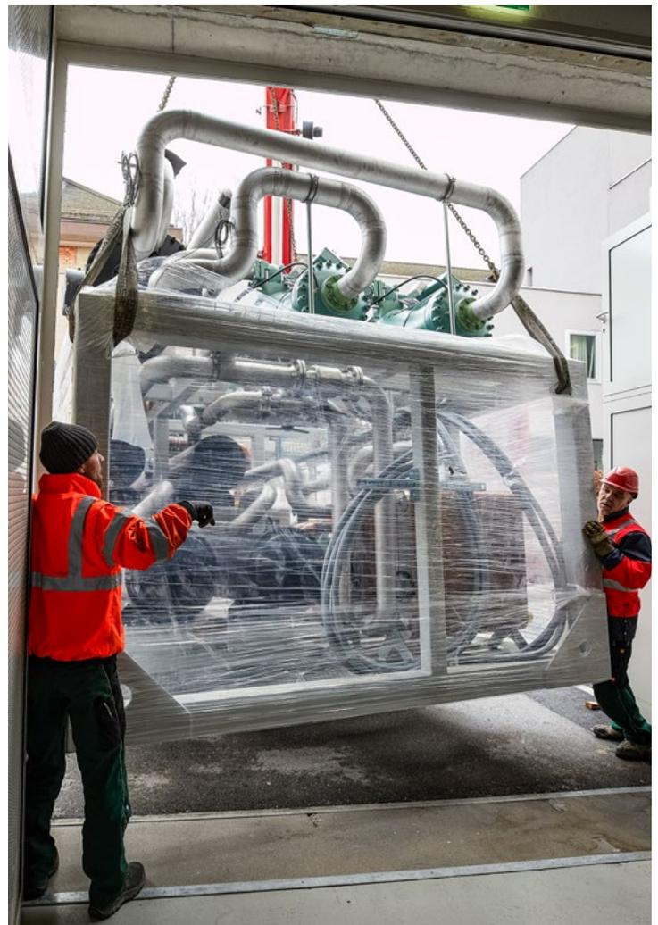
Mise en place de l'installation frigorifique HFO de 1,6 MW dans l'Hôpital de l'île
