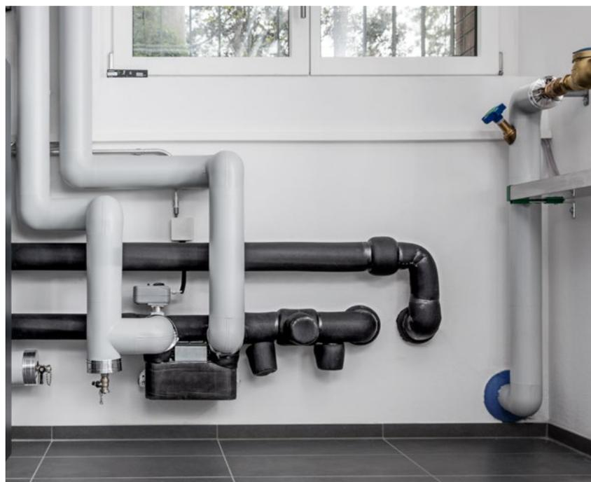
Avec le Free Cooling, un échangeur de chaleur supplémentaire permet de contourner la pompe à chaleur et transfère les températures froides du sol directement au distributeur de chauffage.
