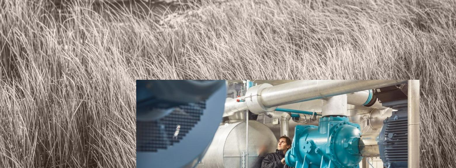
3 x 1,6 MW de puissance frigorifique avec le fluide frigorigène ammoniac
