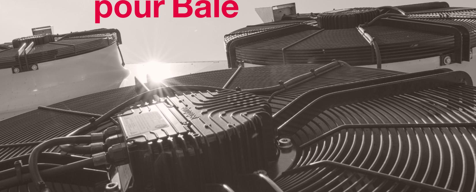
**IWB, le fournisseur d'énergie de Bâle-Ville, a installé en 2018 dans le réseau de chauffage à distance St. Jakob deux pompes à chaleur (PAC) haute température air/eau sur mesure de CTA avec une puissance calorifique totale de 530 kW. Ces PAC remplacent une centrale de cogénération fonctionnant au gaz naturel et contribuent, ainsi, à réduire davantage les émissions de CO<sub>2</sub> liées à l'approvisionnement en chaleur de Bâle.**
