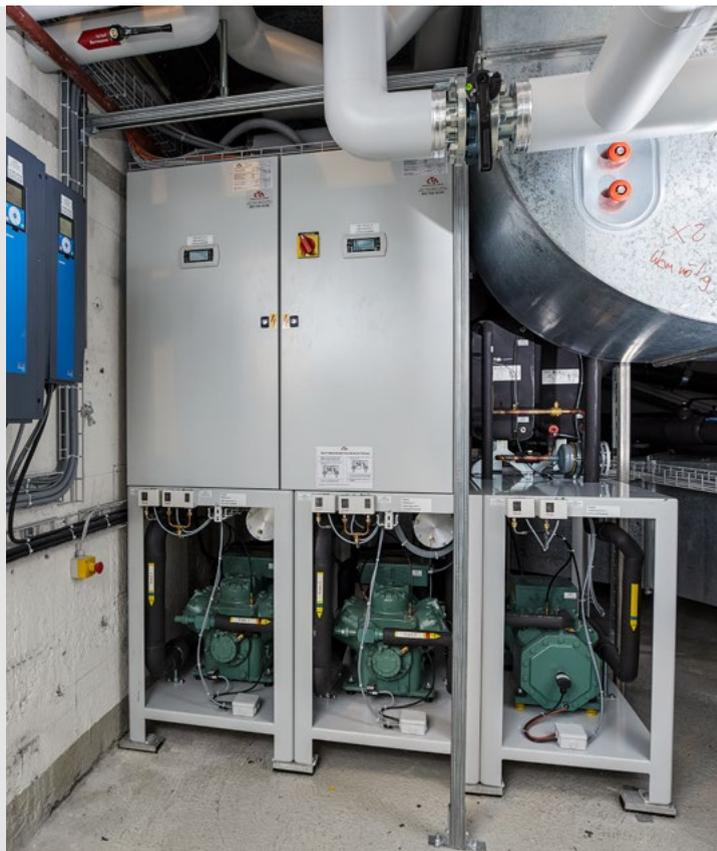
espace. Pour cette raison, les machines ont été conçues de manière à pouvoir être divisées en modules de 90×120 centimètres. L'ensemble du système a ainsi pu être soulevé du quatrième au cinquième étage sans aucun détour par une ouverture d'admission étroite.
