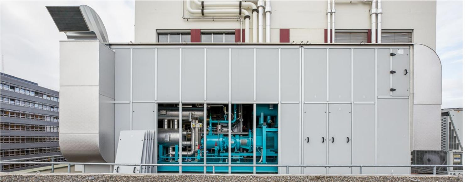
**Deux réseaux de froid indépendants – l'un avec des groupes frigorifiques à l'ammoniac – assurent un refroidissement fiable des processus dans les laboratoires et la climatisation du bâtiment de l'Université de Bâle. Le système est toujours réglé de manière optimale grâce à un accès à distance, de sorte qu'il fonctionne de manière sûre, efficace et économique.**
