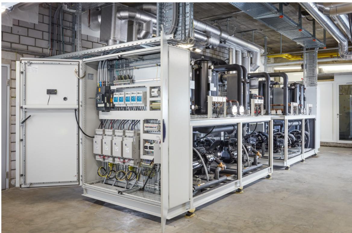
Image: Refroidisseur à air à la saumure et pompes à chaleur posée à l'intérieur (ouvertes) d'un système de pompe à chaleur air/eau CTAexklusiv avec une puissance de chauffage de 530 kW (Réseau de chauffage à distance St. Jakob, Bâle).
