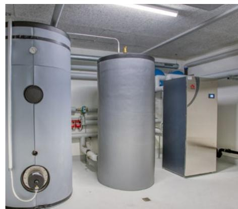
Avec une puissance sonore de 39 dB(A), l'unité intérieure dotée de deux couches d'isolant est aussi silencieuse qu'un réfrigérateur domestique.
